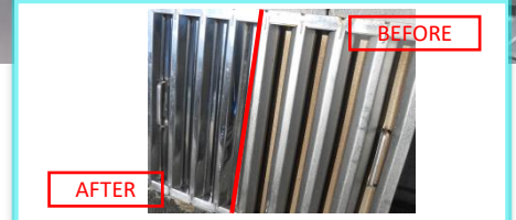
グリスフィルターの洗浄
